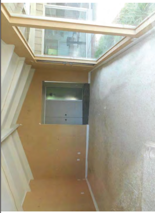
View of 804 Alameda De Las Pulgas interior
