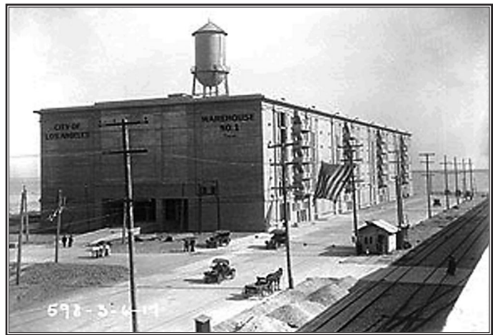
Warehouse No. 1, 1917 (Queenan 1983).
