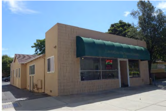
Figure 41. 870 N. First Street.
