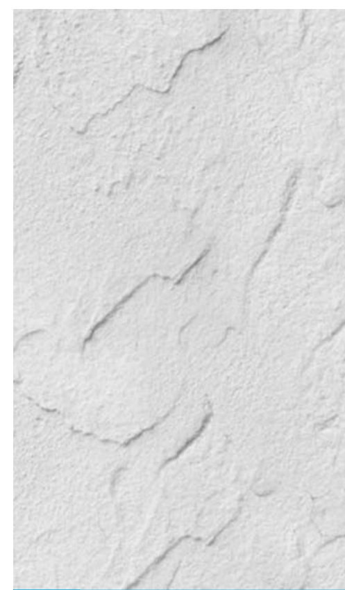
A TROWEL STUCCO FINISH //
