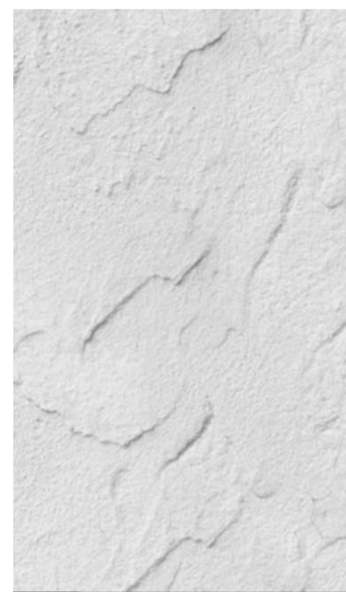
A TROWEL STUCCO FINISH //
