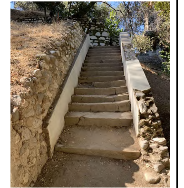
EXISTING CONDITIONS SCALE: N.T.S.
