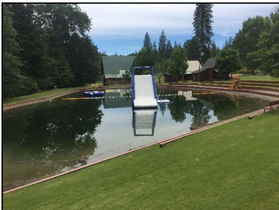
Existing Pond Area
