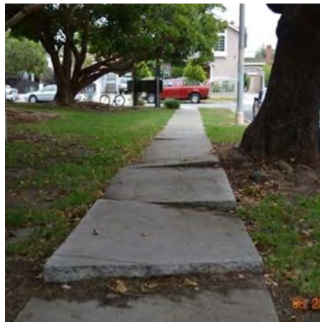
Levantamiento de acera
